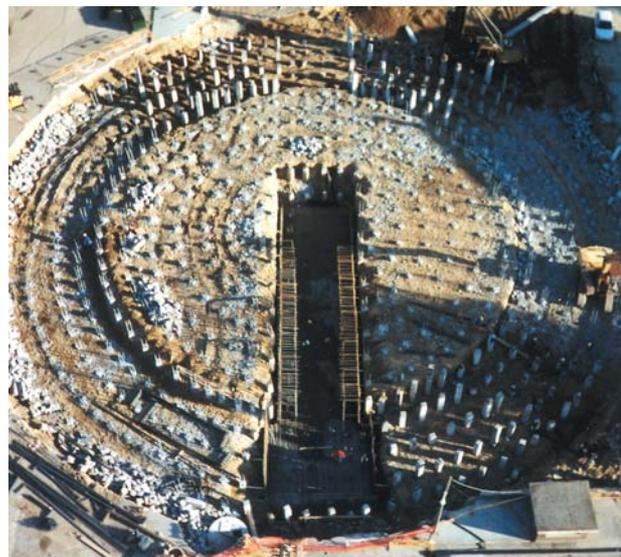
Cimentación mediante pilotes prefabricados Terra del nuevo silo de azúcar de 75.000 Tn de carga útil en la Fabrica de Benavente (Zamora)
