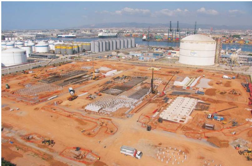
Cimentación mediante pilotaje prefabricado y pretensado de Central de Ciclo Combinado en el Puerto de Barcelona
