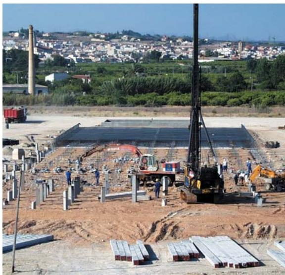
Cimentación mediante pilotes prefabricados y descabezado de pilotes de nueva nave almacén frigorífico para Hero España. Alcantarilla (Murcia)
